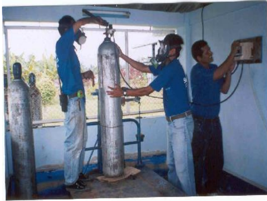
Vista de Caseta de Cloración N° 1
