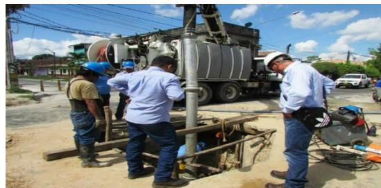
Camión Hidrojet realizando labores de desatoro alcantarillado
