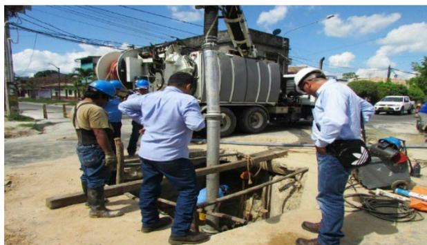
Camión Hidrojet realizando labores de desatoro alcantarillado
