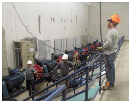
Instalación de bombas para la mejora del sistema de bombeo
